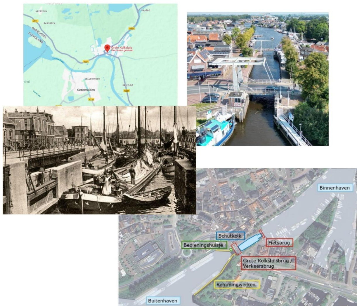
Figuur 2 De locatie van de Grote Kolksluis (linksboven), een overzichtsfoto van het sluiscomplex (rechtsboven), een historische foto van de sluis (midden, overgenomen uit het Bouwhistorisch onderzoek), een overzicht van de onderdelen van het sluiscomplex (rechtsonder).
