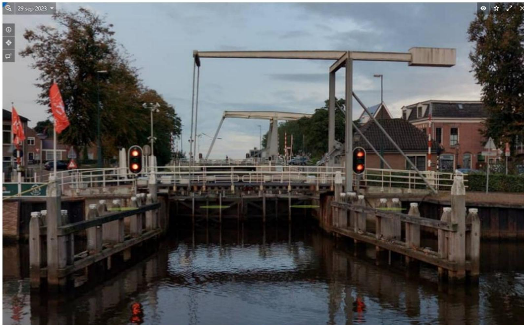
Figuur 4 Vooraanzicht vanaf het binnenwater [Cyclomedia, opnamedatum 29 september 2023]
