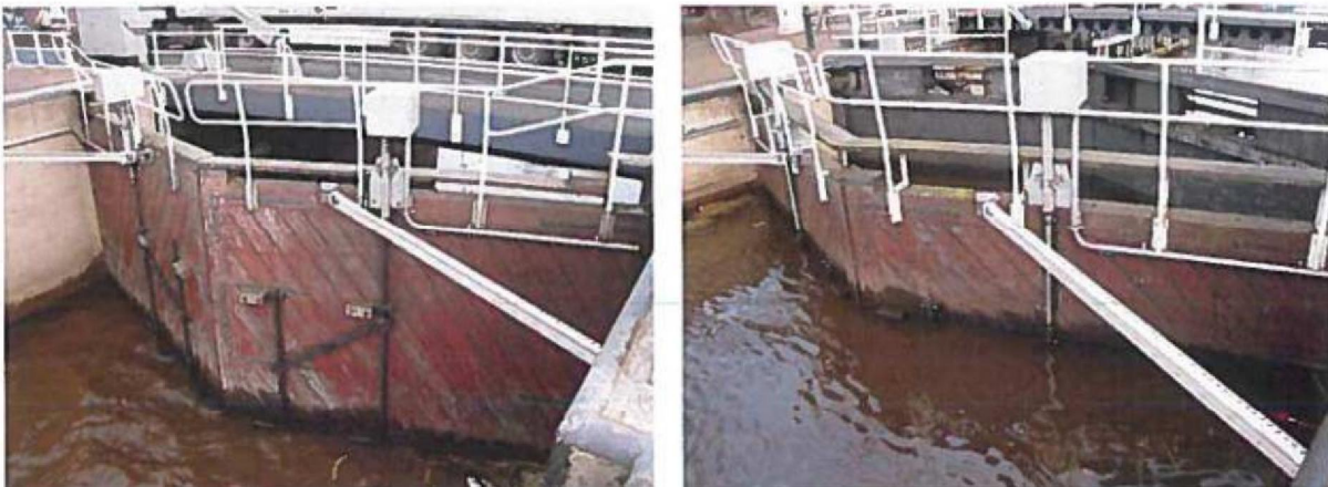
Figuur 3-4 Sluiscomplex Grote Kolk. Vloeddeuren in buiten- en binnenhoofd. Overgenomen uit [P4].
